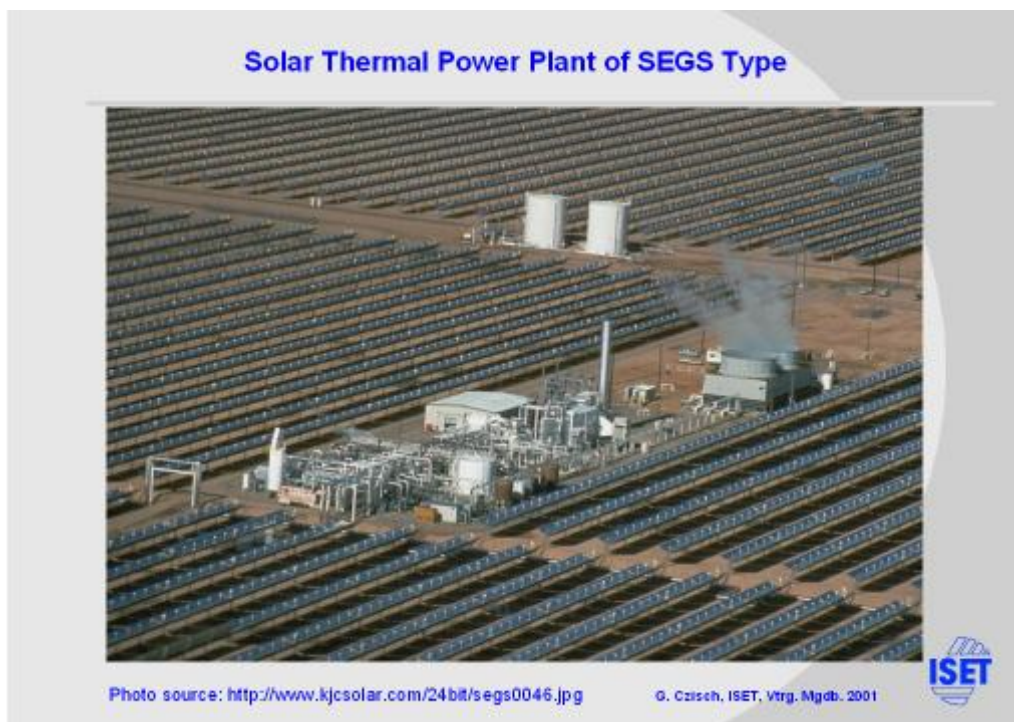
Σχήμα 4.7 Πεδίο παραβολικών συλλεκτών σε σταθμό παραγωγής ηλ. ενέργειας στο Cramer Junction στις Η.Π.Α.
