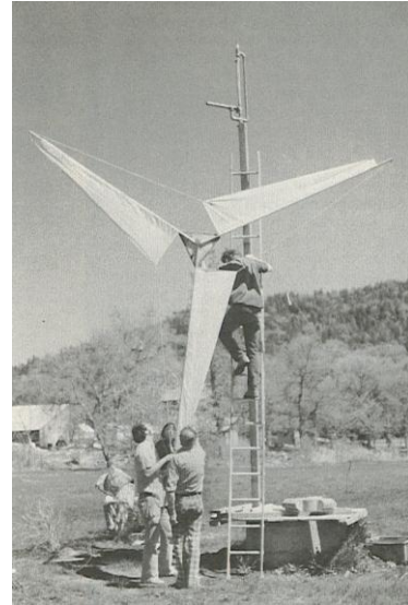
Σχήμα 6.1 Ανεμομηχανές οριζοντίου άξονα. Αριστερά ο κλασσικός Αμερικάνικος ανεμόμυλος –American Farm Wind Mill- ο οποίος χρησιμοποιήθηκε και χρησιμοποιείται για άντληση νερού και σε πολλές περιοχές της Ελλάδας. Δεξιά ο ανεμόμυλος με πανιά μια παραλλαγή του δικού μας ανεμόμυλου που χρησιμοποιήθηκε για αιώνες για την άντληση νερού, το άλεσμα της σοδειάς και άλλες εργασίες.
