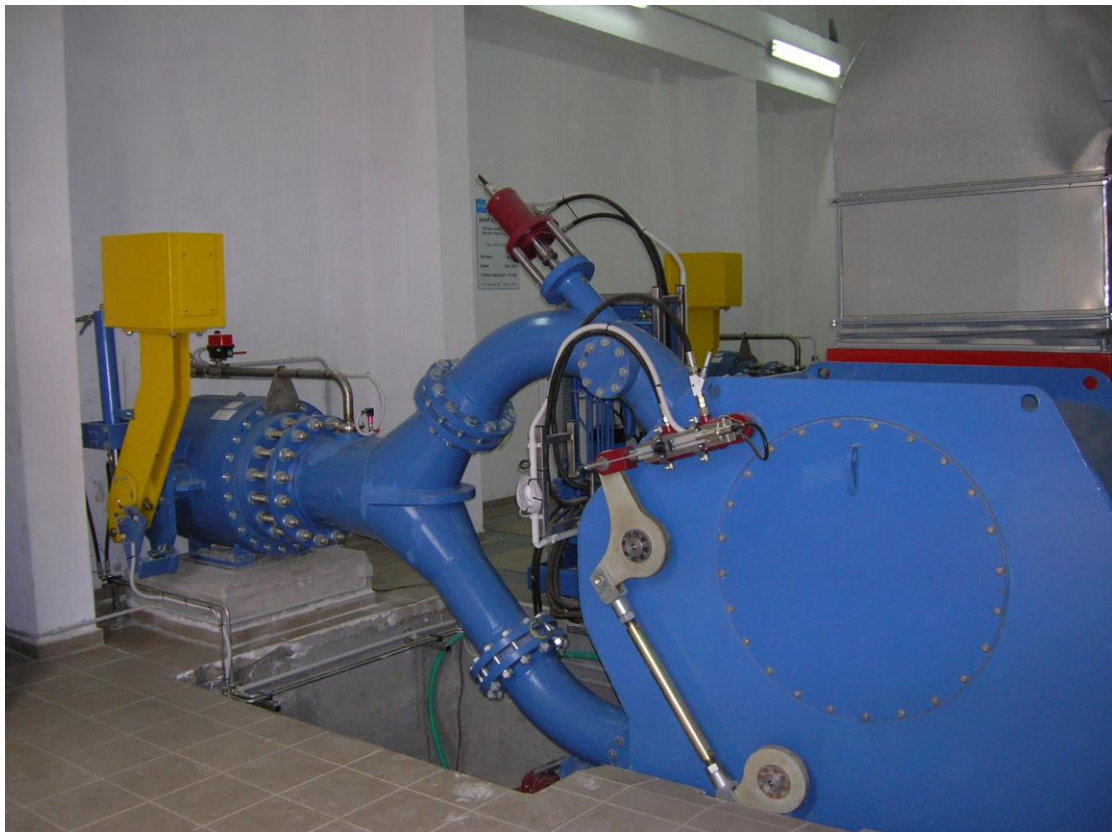
Σχήμα 7.6 Σχεδιάγραμμα και φωτογραφία υδροστροβίλου μικρού Υ/Η.
