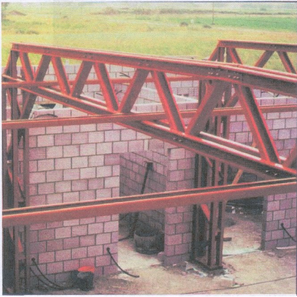
Σχ. 8.1 Παραδείγματα δικτυωμάτων
