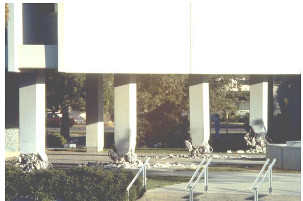
Σχήμα 2.41. Αστοχία μαλακού ορόφου (Σεισμός Imperial Valley M=7.0, California, 15/10/1979, φωτογραφία από Bertero, Vitelmo V. - Earthquake Image Information System, NISEE, University of California, Berkeley)
