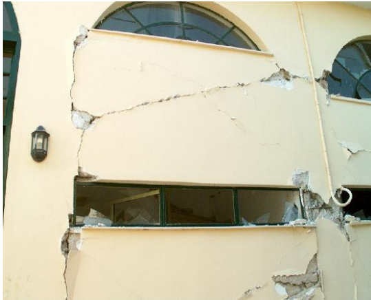
Σχήμα 2.48. Κτίριο με σημαντικές βλάβες κατά τον σεισμό της Λευκάδας M=6.4 στις 13/08/2003 (α) φωτογραφία του κτιρίου, (β) αριθμητικό προσομοίωμα, (γ)-(δ) αστοχία καμπητικού τύπου στη βάση των υποστυλωμάτων, (ε)-(στ) διαμητική αστοχία εκρηκτικού τύπου σε κοντά υποστυλώματα (πηγή: Sextos et al, 2005 )
