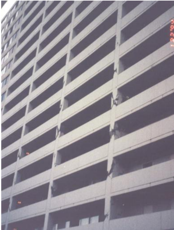
Σχήμα 2.46. Αστοχία κοντών υποστυλωμάτων – διακρίνεται η μόρφωση του κοντού υποστυλώματος λόγω του μη φέροντος τοιχείου χαμηλού ύψους στα μπαλκόνια (Σεισμός Northridge M=6.7, California, 17/01/1994, φωτογραφία από «Northridge Earthquake Reconnaissance Report, Earthquake Spectra: The Professional Journal of EERI, Earthquake Engineering Research Institute (USA) 1996 2»)
