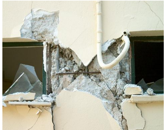
Σχήμα 2.48. Κτίριο με σημαντικές βλάβες κατά τον σεισμό της Λευκάδας M=6.4 στις 13/08/2003 (α) φωτογραφία του κτιρίου, (β) αριθμητικό προσομοίωμα, (γ)-(δ) αστοχία καμπητικού τύπου στη βάση των υποστυλωμάτων, (ε)-(στ) διαμητική αστοχία εκρηκτικού τύπου σε κοντά υποστυλώματα (πηγή: Sextos et al, 2005 )
