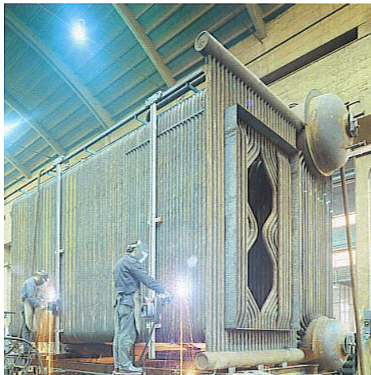
Σχήμα 5.4 βιομηχανικός υδραυλωτός ατμολέβητας στη φάση της κατασκευής - συγκόλληση των αυλών οι οποίοι διαμορφώνουν τους θαλάμους καύσεως -στη συγκεκριμένη περίπτωση 2-. Διακρίνονται το άνω και κάτω τύμπανο του ατμολέβητα.
