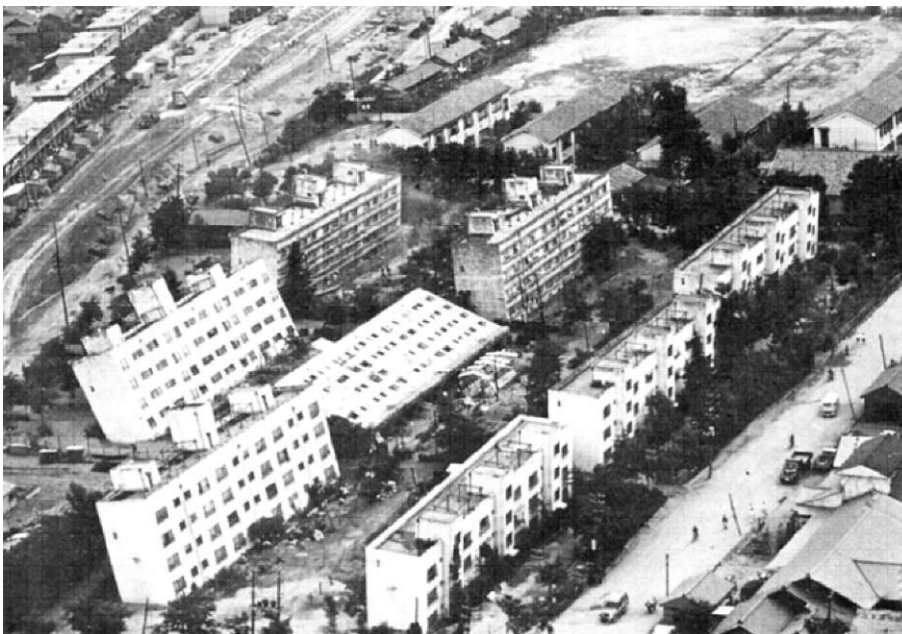
Καταστροφή οικοδομών εξαιτίας της ρευστοποίησης του υποβάθρου θεμελίωσης κατά τη διάρκεια σεισμού. Οι οικοδομές δεν υπέστησαν ζημιές, έγειραν άθικτες. (Φωτο. G. Housner, California Institute of Technology)
