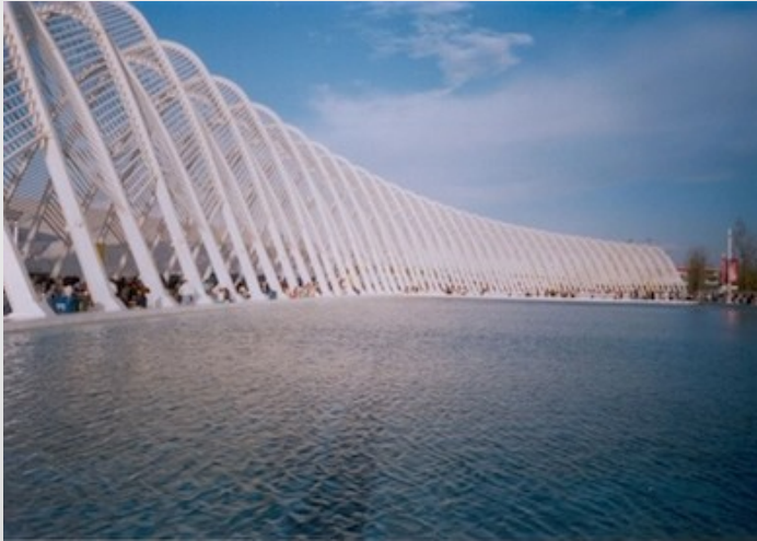
Οριζόντια επιφάνεια νερού - ΟΑΚΑ
