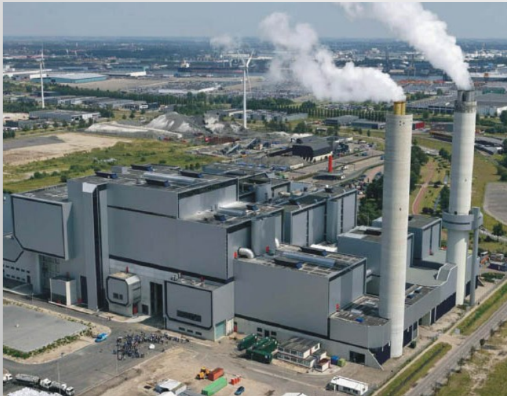
Μονάδα καύσης απορριμμάτων
